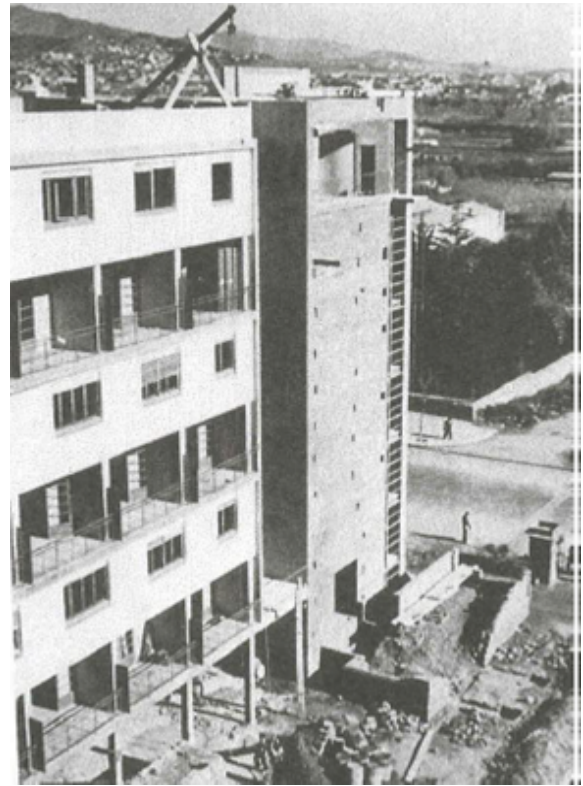
Figura 1 8 . Imatge de la construcció de l'Edicle
