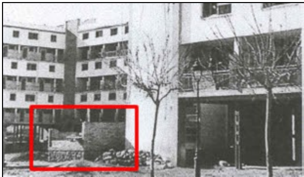
Figura 2 10 . Imatge de la construcció de l' Edicle
