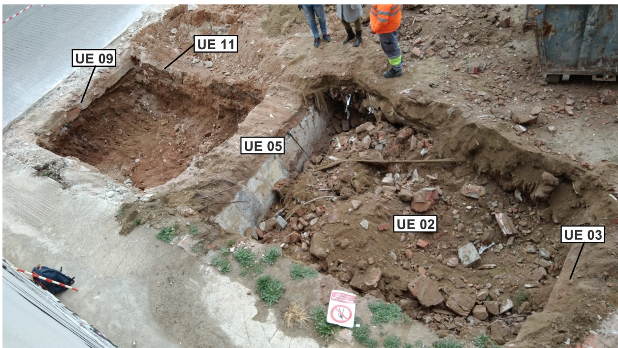
4.- Vista general de la cala acabada d'obrir.
