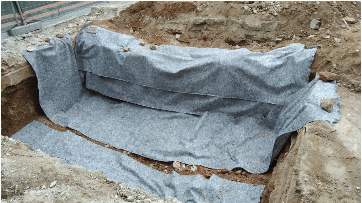
9.- Vista del procés de cobriment de les restes amb geotextil.
