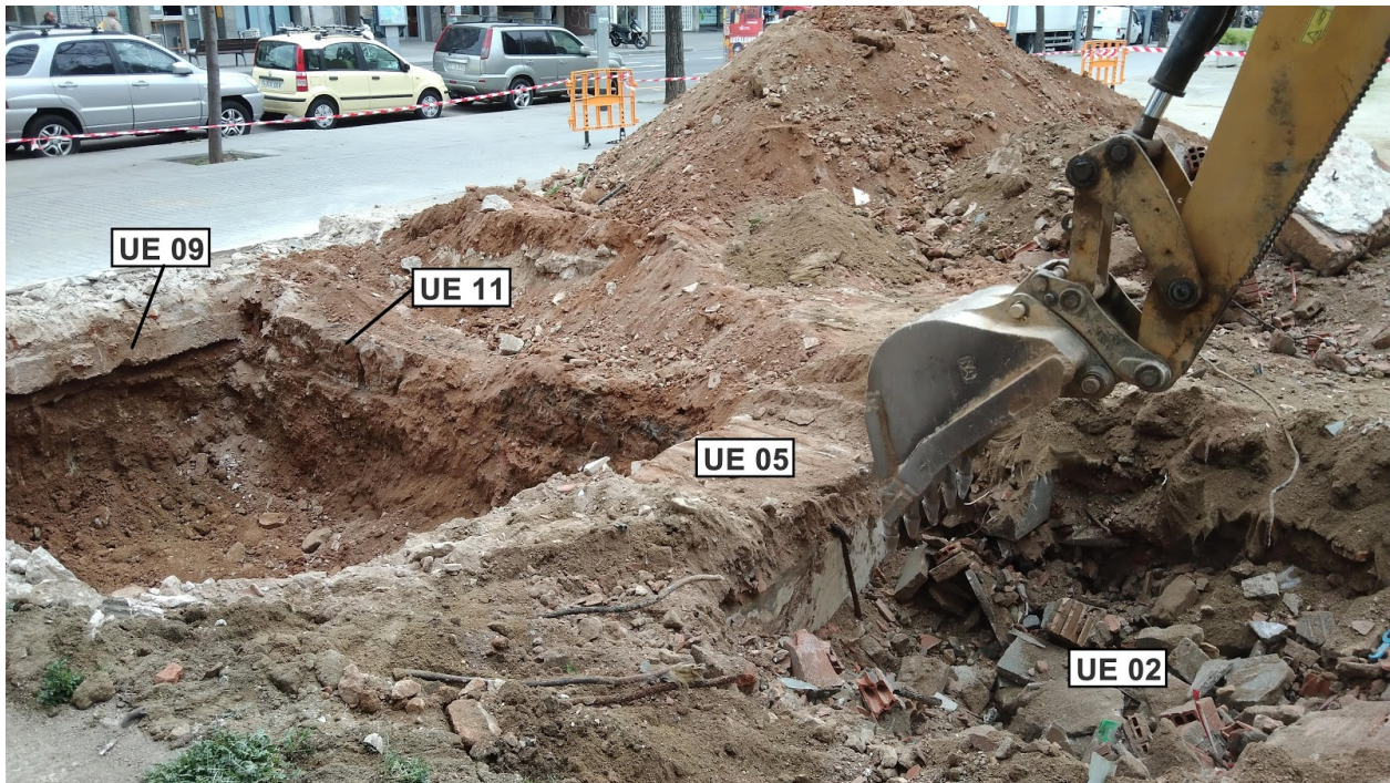
3.- Vista del procés d'obertura de la cala.
